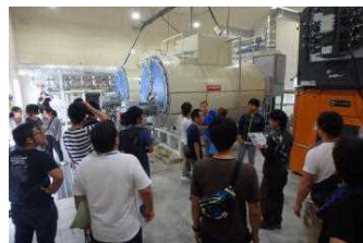
ガスボイラーと木質ボイラー
